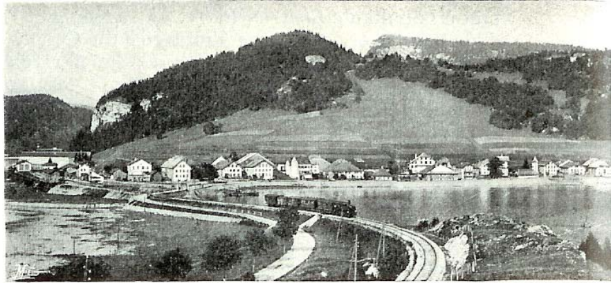
Le Pont : Vue générale.
